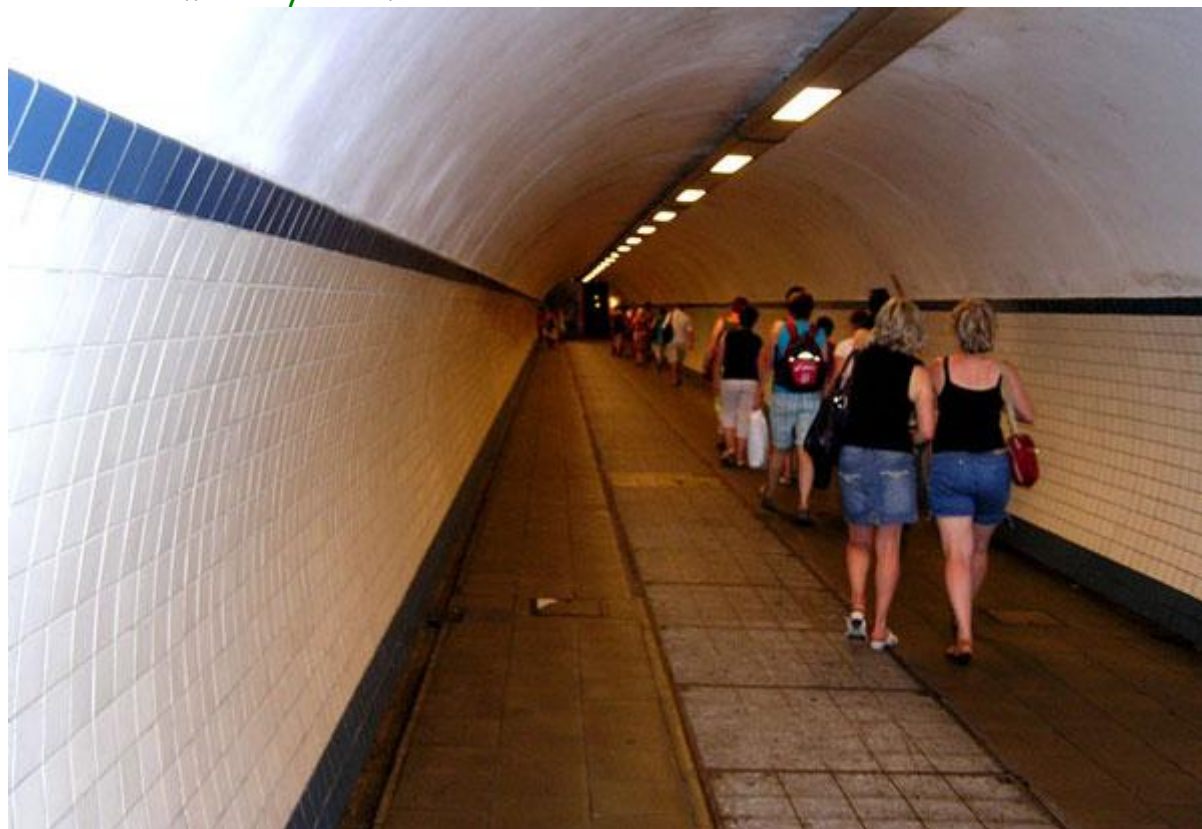
Blisko 800 metrowy tunel.
