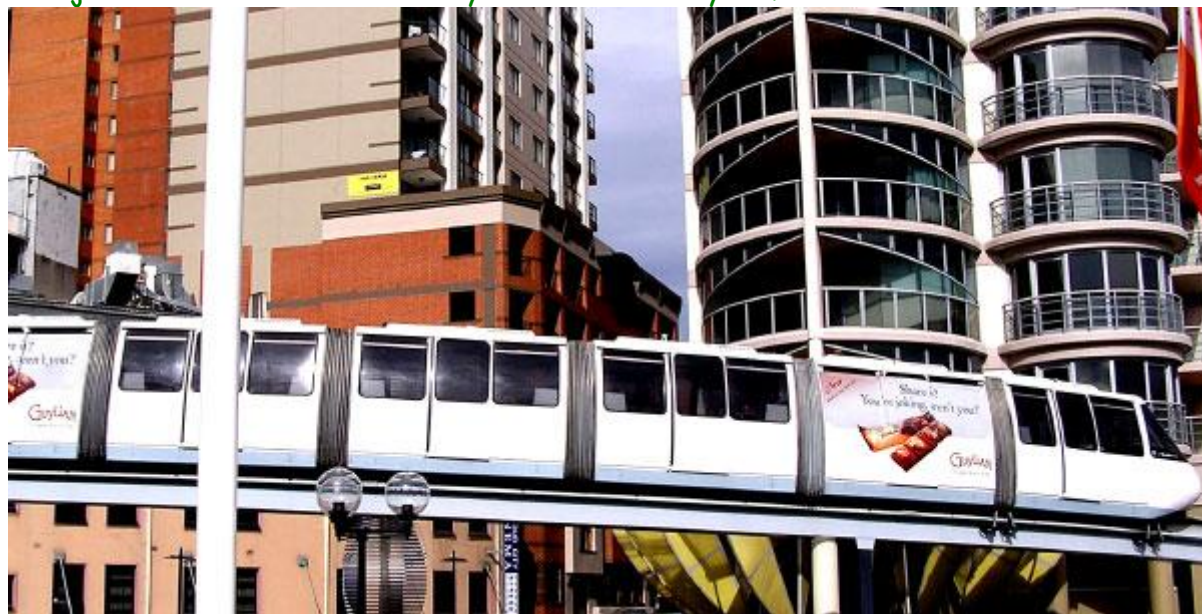
Kolejka na torach zainstalowanych na nadziemnych filarach..
